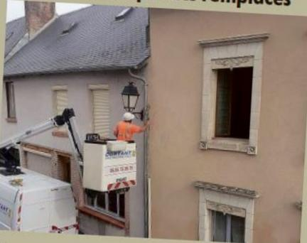
**ÉCLAIRAGE.** Le remplacement de 75 luminaires sur l'éclairage public a été réalisé pour un gain estimatif de puissance de 60 % et une économie de 85 % par an. Prise en charge à 65 % par la fédération départementale d'électrification et d'énergie de la Corrèze et de 15 % par le conseil départemental.
